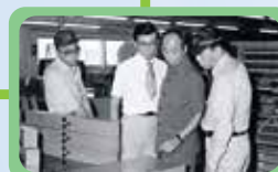
引進海外混凝土預製件生產技術
